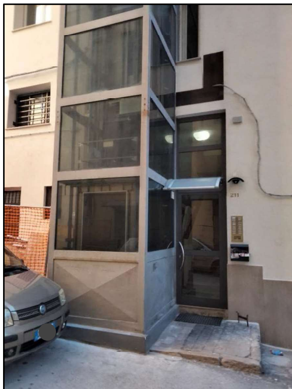
Particolare Ascensore esterno
